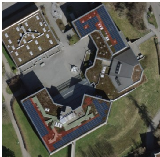
Abb. 2: Dachansicht Grünau 1 und Verwaltung
